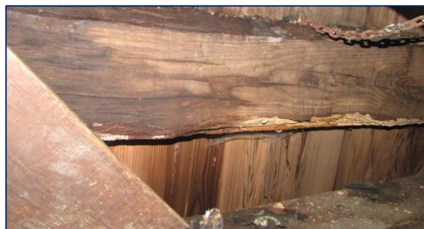
Detail aantasting houten lijsten Heechhiem
