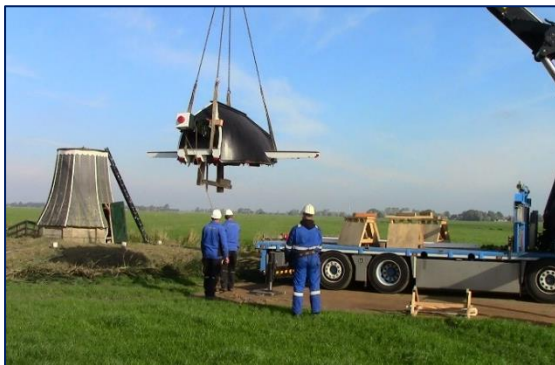
De kap van de Volharding in de takels na herstel.
