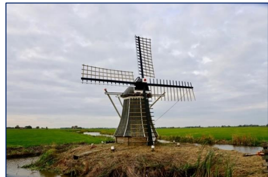
Het nieuwe gevlucht van De Volharding is geplaatst.
